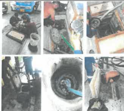
รูปที่ 8 การสูบน้ำตะกอนส่วนเกินจากระบบบำบัดน้ำเสีย
